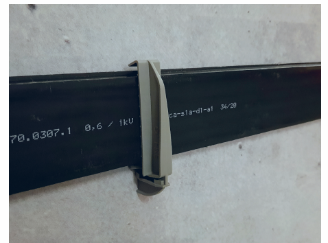
Bild 3: Beispiel Flachbandkabel mit FKE montiert
